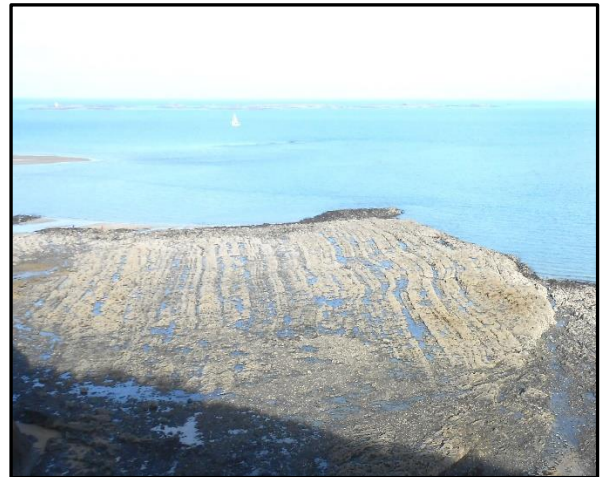
Fig.131 Vue du chemin des douaniers
