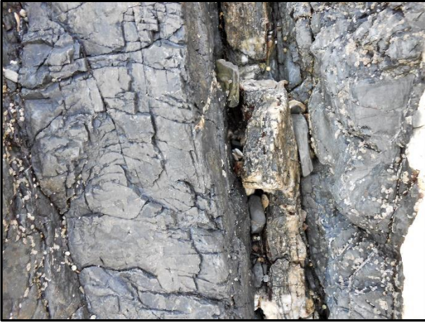
Fig.31 injection de silice entre deux bancs de grès
