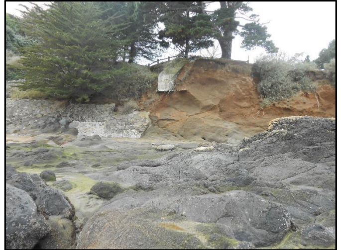
Fig.147 : érosion de la diorite sous le blockhaus
