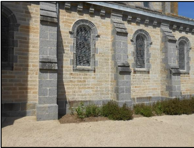
Fig.21 : Eglise Saint-Pierre d'Eréac, utilisation de la diorite de Langourla et d'un granite clair (Languédias ?)
